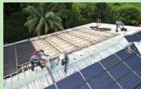
Pose de panneaux photovoltaïques Bâtiment Services Techniques - (Novembre 2023)
