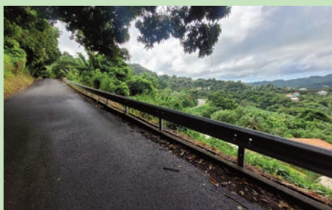
Mise en place d'une glissière de sécurité Quartier Firmin - (Décembre 2023)
