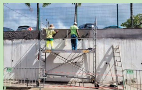
Réfection du mur rue Capitaine Pierre Rose - (Novembre 2023)
