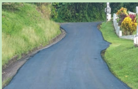
Réfection de la chaussée en enrobés Quartier Suin - (Janvier 2024)
