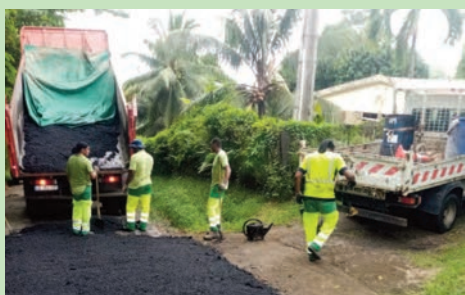
Travaux d'enrobés Bois Michel - (Novembre 2023)
