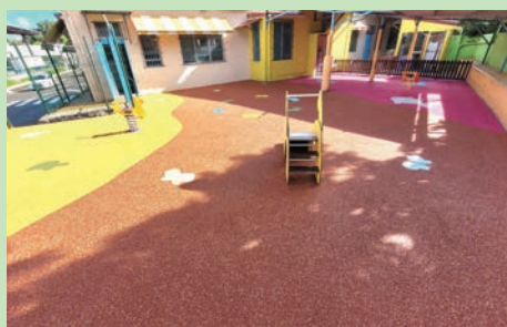
Réfection du revêtement souple de la cour de la Crèche "Les Boutons d'Or" - (Novembre 2023)
