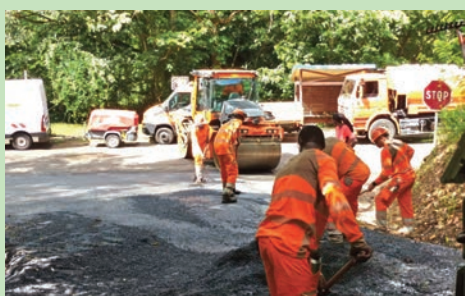
Travaux de création de fossés bétonnés au quartier Nau - (Septembre 2023)
