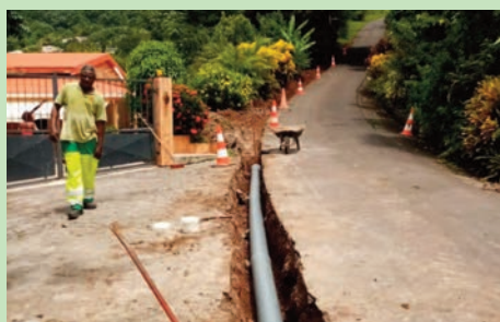
Travaux de canalisation des eaux de surface / Vieilles Terres - (Octobre 2023)
