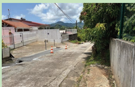
Travaux d'accotement Quartier Morne Lavaleur - (Août 2023)
