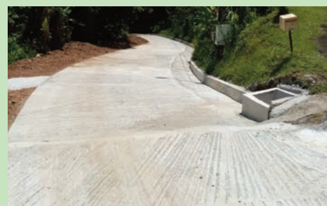
Réfection de la chaussée Quartier Fonds Coulisses - (Septembre 2023)
