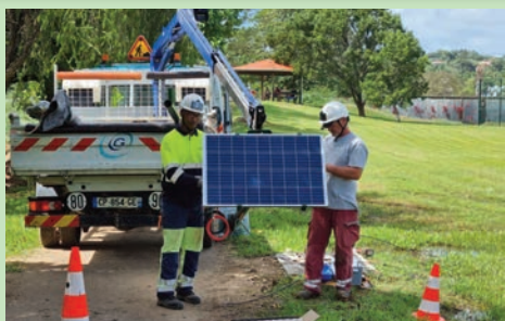
Installation de lampadaires solaires Parcours santé - (Janvier 2024)
