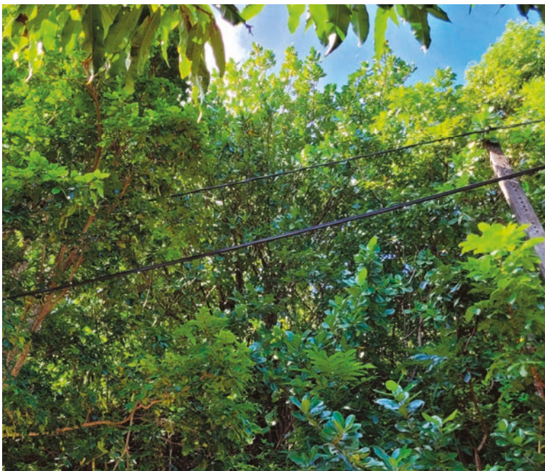
Lignes électriques recouvertes par la végétation (Nau)
