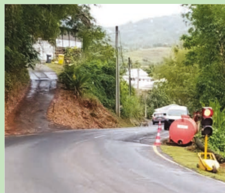
Des travaux de soutènement de la RD5 ont débuté le 2 janvier 2023
