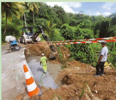
Travaux de réfection de la chaussée quartier Fonds Coulisses (juillet 2022)
