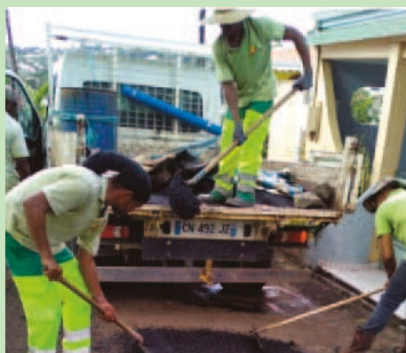
Travaux d'enrobé rue du Morne Rouge (décembre 2022)
