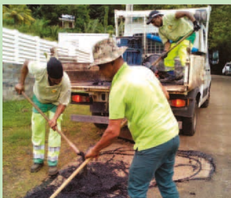
Travaux d'enrobé quartier Mathilde (décembre 2022)
