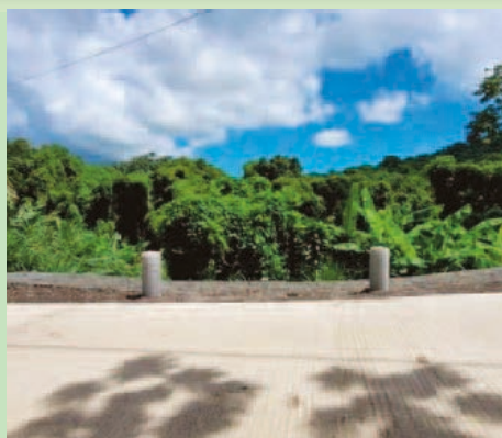
Travaux de réfection de la chaussée achevés quartier Fonds Coulisses
