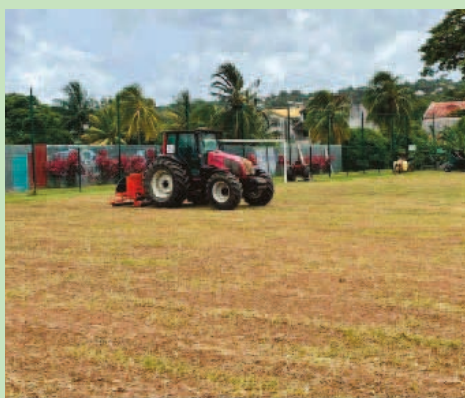
Travaux de rénovation du terrain annexe 1 (août 2022)
