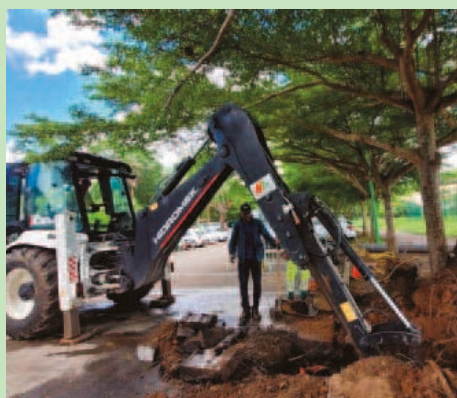
Création d'une canalisation d'évacuation des eaux pluviales (septembre 2022)
