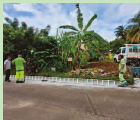
Travaux de réfection des accotements au quartier Morne Lavaleur (octobre 2022)
