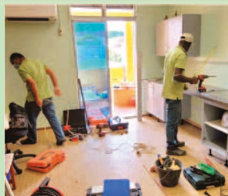
Travaux de menuiserie et de plomberie au CCAS (Juillet 2022)
