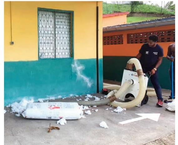
*Travaux d'isolation thermique sous la toiture de l'école de Grand Bassin (août 2020).*
